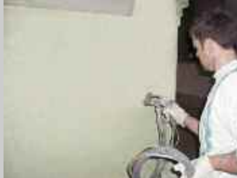
1 Putzauftrag maschinell
