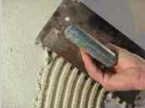
1 Putzauftrag manuell
